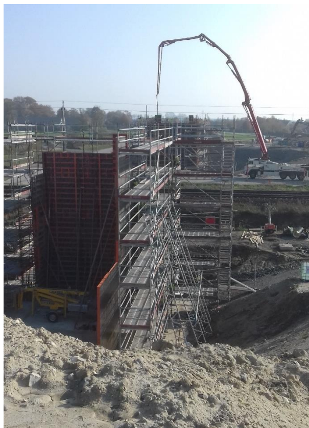
Formar är på plats och betong fylls på.
