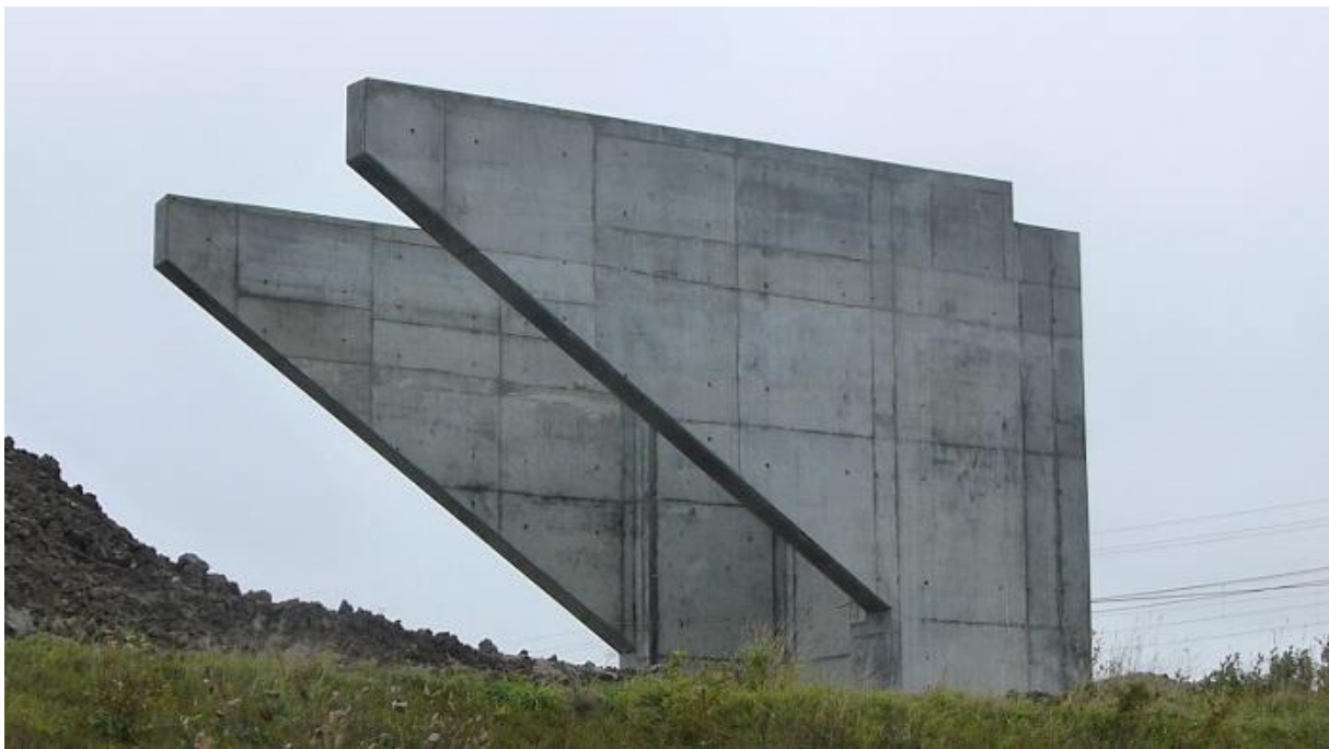
Naket brofundament. Mellan vingarna fylls material och packas för att bli vägbana.
