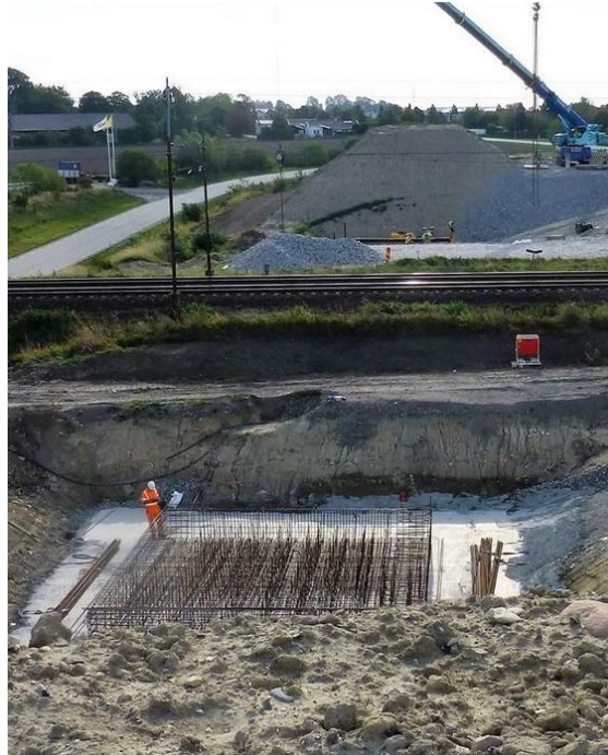
Bottenplatta med armeringsjärn är gjuten.
