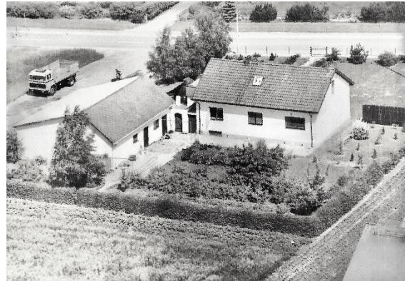
Huset sett från söder. Bild från år 1971.
