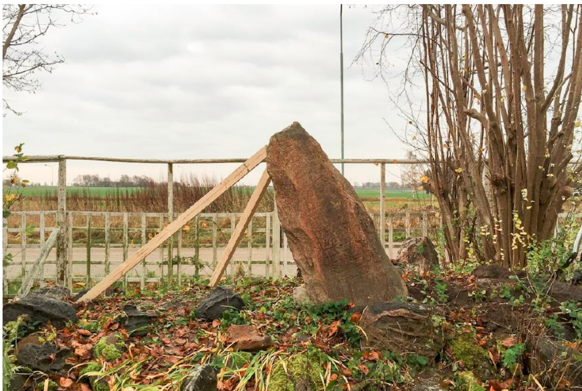
Bild 34 Runstenen säkras innan arbetena påbörjas. Fotograf Stucco Maestro.
